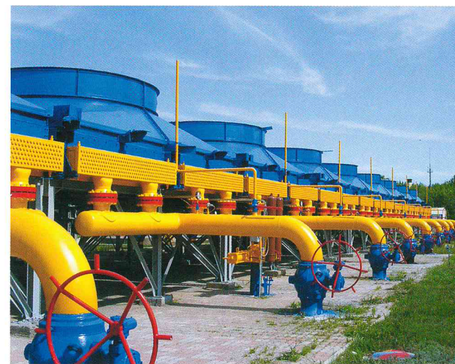
ООО «Газпром трансгаз Самара». Капитальный ремонт Тольятинского ЛПУ МГ
